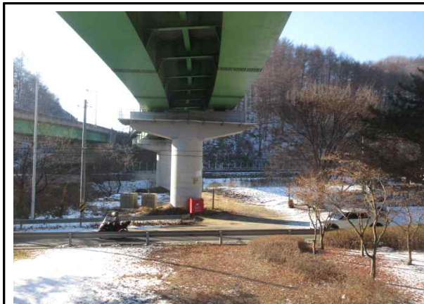
교각 P1 전경
