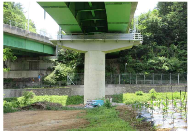
교각 P2 전경
